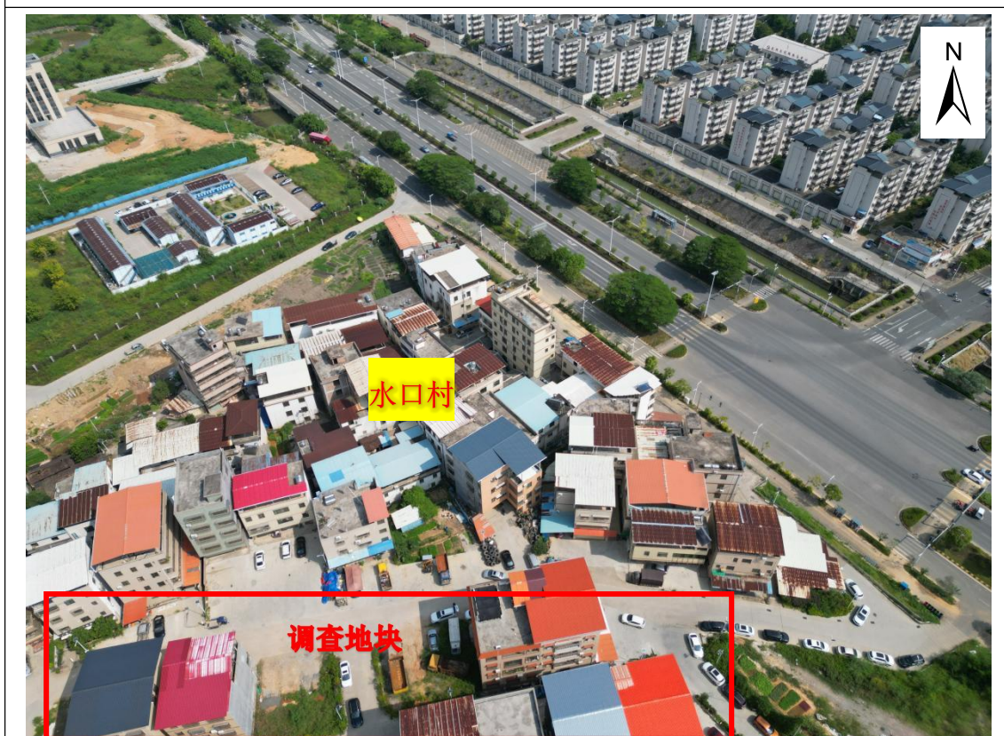
地块北侧—航拍
